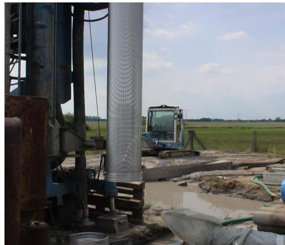
**Bild 2** Einbau Wickeldrahtfilter V4A DN 300
